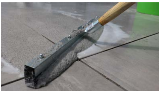
Mit Hilfe eines Gummischiebers die Fugenmasse einschwämmen. Nach der Verfugung die Flächen mit einem Besen abkehren
