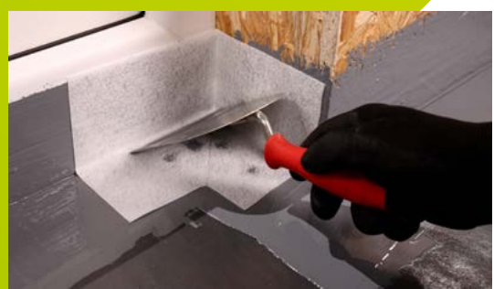
Vorgeformte Innen-/Außenecken werden in die erste Schicht eingebracht
