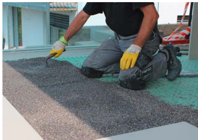
Verlegung im Epoxi-Mörtelbett aus codex ER 100 und DS 3/5
