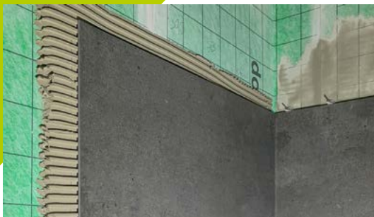
Leichtes Auftragen des codex Power CX 7 auf Wand- und Bodenflächen durch variabel einstellbare Konsistenz
