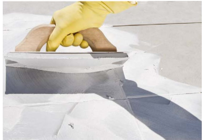
Verfugung des Fliesenbelags mit codex X-Fusion
