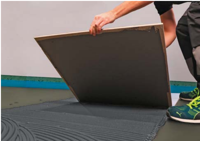
Zur besseren Anhaftung bei der Verlegung Buttering-Floating-Verfahren anwenden
