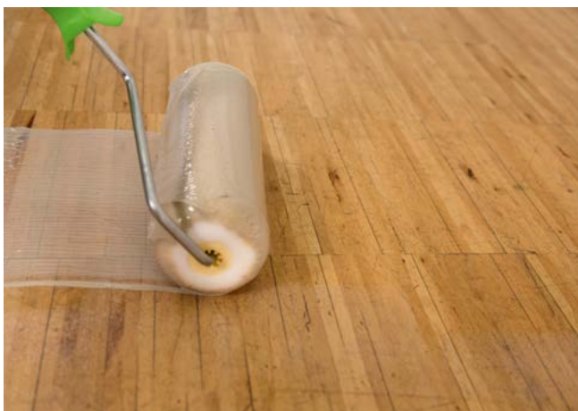
UZIN Unifix auf vorbereiteten Untergrund aufbringen
