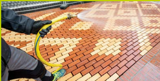
Alle Belagselemente gut vornässen
