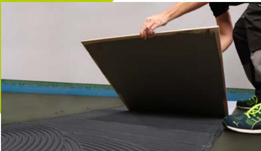
Mit codex Power RX 11 Outdoor werden Feinsteinzeugfliesen im Format 100 x 100 cm als Balkon- und Terrassenbelag verlegt
