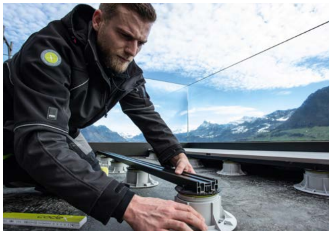
Durch drehen von BL Tower wird die Höhe für ein waagrechtes Auflegen der Platte eingestellt
