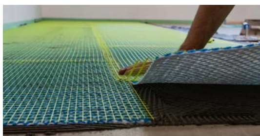
3. Matten stoßversetzt verlegen
