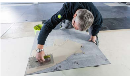
Mit drei Stunden Topfzeit hat codex Power RX 4 Ultra ein langes Verarbeitungszeitfenster und kann ideal im Floating und Buttering-Floating-Verfahren verlegt werden
