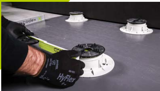
Positionieren der BL Tower auf Plattenmaß
