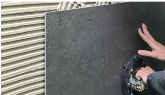
Einfach Verlegung von großformatigen Fliesen an der Wand durch seine extreme Standfestigkeit
