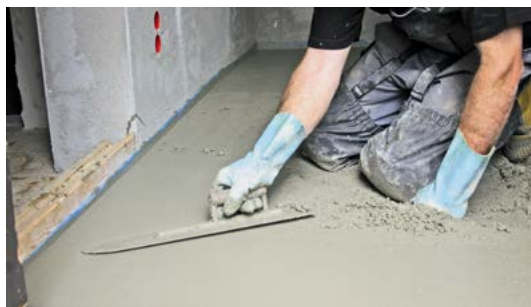
Glätten der Estrichoberfläche mit dem Estrichschwert
