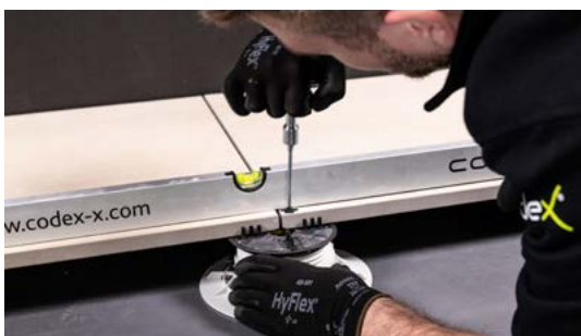
Platten werden am Drehteller des BL Tower per Hand in der Höhe eingestellt. Anschließende Feinjustierung mit BL Key möglich
