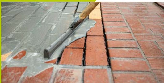
Pflasterfugenmörtel X-Terra Street B mit einem Gummischieber einschlämmen
