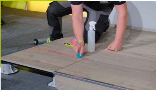
Verfugen von Terrassenplatten verlegt mit codex BalkuLift
