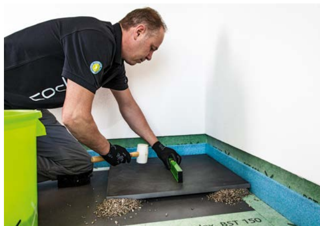
Je nach Plattendicke/-größe Belag auf 4 – 6 Batzen verlegen
