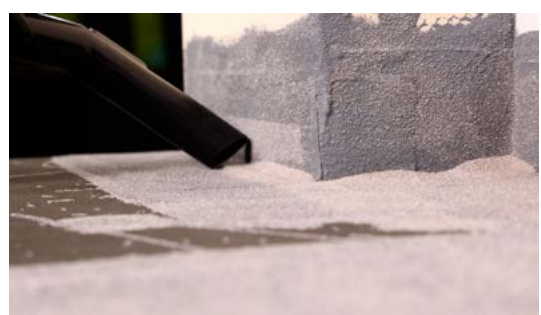
Durch Absandung ist eine zementäre Verlegung mit codex Power RX 11 Outdoor möglich, ohne Absandung mit codex Fliesopur
