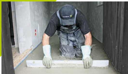
Abziehen des Estrichs auf den Lehren
