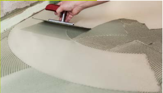
1. codex AX 230 in den Ecken vorlegen und Formteile einbringen
