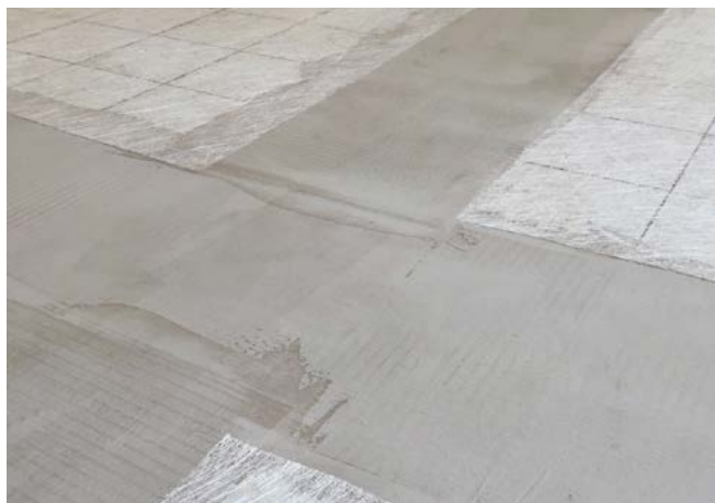
Schlitze mit EX 24 füllen bevor RR 203 mit RX 6 Turbo eingespachtelt wird
