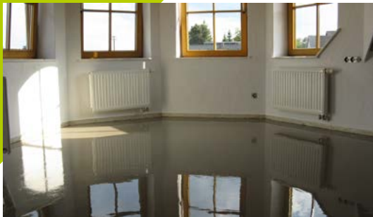
Selbstverlaufende Bodenspachtelmasse mit breitem Schichtdickenbereich und optimalen Fließeigenschaften, ideal auch für den schnellen Baufortschritt besonders in der Sanierung
