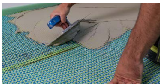
4. Gitterstruktur mit Verlegemörtel absachteln und dann mit geeigneter Zahnung Frisch-in-Frisch aufziehen
