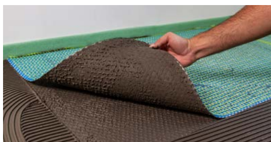
2. codex UX 430 in den Mörtel einlegen und gut anreiben
