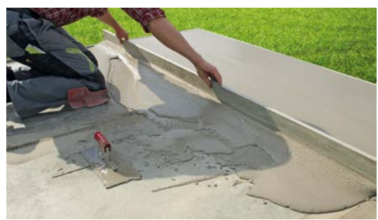
Gefälle bis max. 4 % mit Richtlatte herstellen
