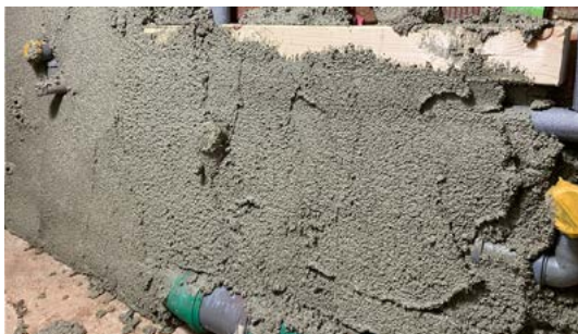
Schließen von Leitungskanälen und Verfüllen der Installationsebenen mit FM 388 Light bis zu 15 cm Dicke in einem Arbeitsgang
