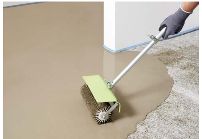
Renoviervlies UZIN RR 201 mit Fliesenspachtelmasse codex FM 50 Turbo
