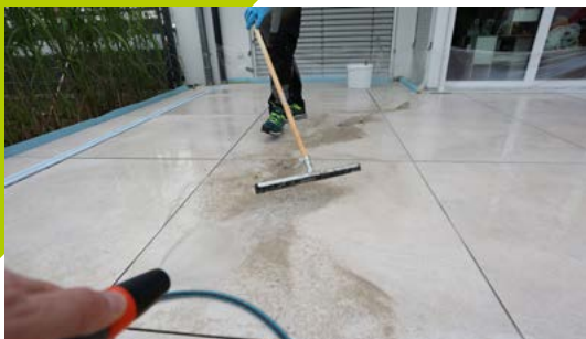
Die Fläche vorab vollständig vernässen und codex X-Terra Base 3 unter Zugabe von viel Wasser einarbeiten
