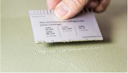
2. Kontaktschicht aufziehen und anschließend erste Schicht mit 4 mm Zahnung aufkämmen und glatt umlegen. Nach Trocknung zweite Schicht auftragen
