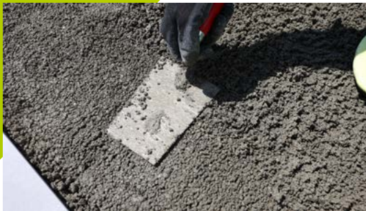
Die spezielle Sieblinie sorgt für eine hohe Wasserdurchlässigkeit
