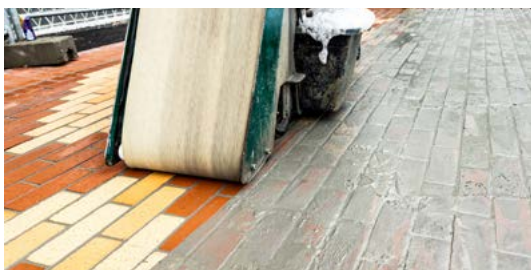
Belagselemente mit Schwammputzmaschine oder bei kleineren Flächen mit Schwambrett abwaschen
